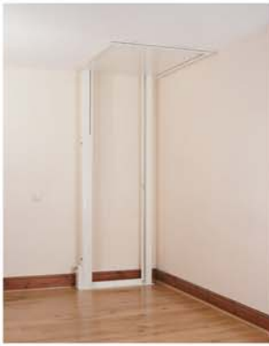
Rez-de-chaussée lorsque l'élévateur est à l'étage supérieur
